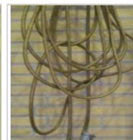
Werkaarding - handmatig aanbrengen van aarde. Doorsnede 9mm veel adrig verting koper plastic omhulsel
