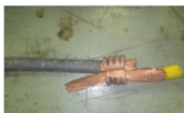
Kabel aardnet Doorsnede 21mm.
