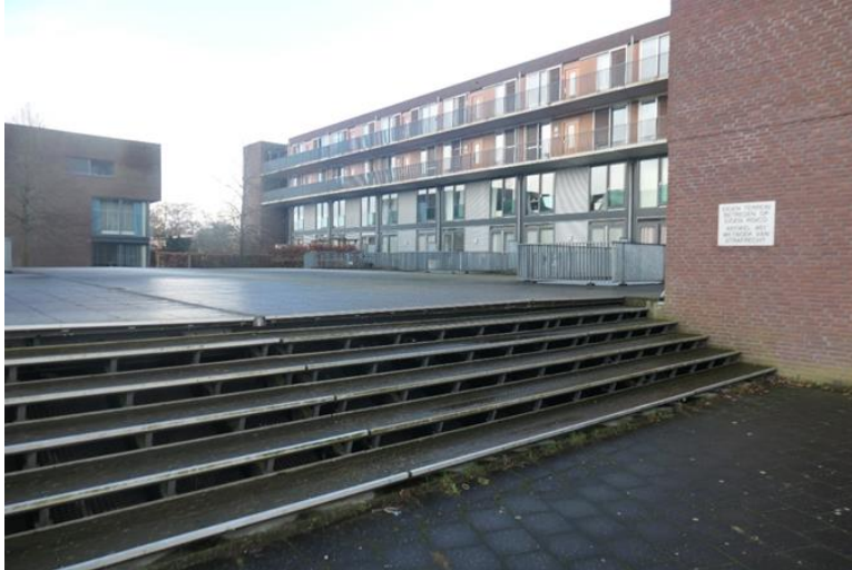
Afbeelding: Opgetild dek met gebodsborden boven een half verdiepte parkeergarage op het Ananasplein in Amsterdam Noord.
