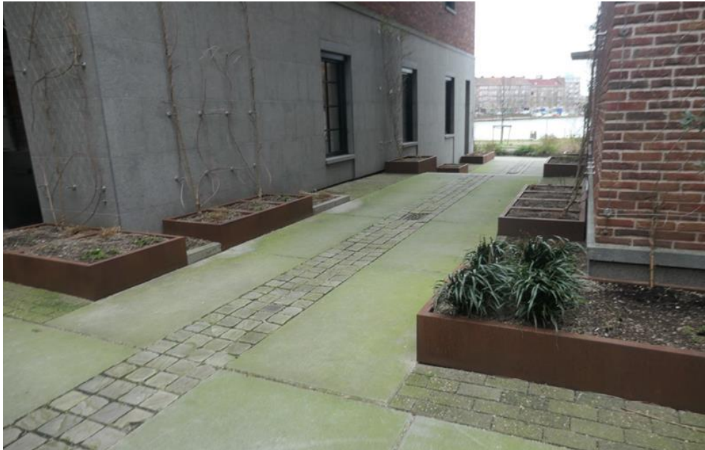
Afbeelding: Plantenbakken van gecorrodeerd staal verlenen naast robuustheid ook eigenheid bij Little C in de Coolhaven in Rotterdam.
