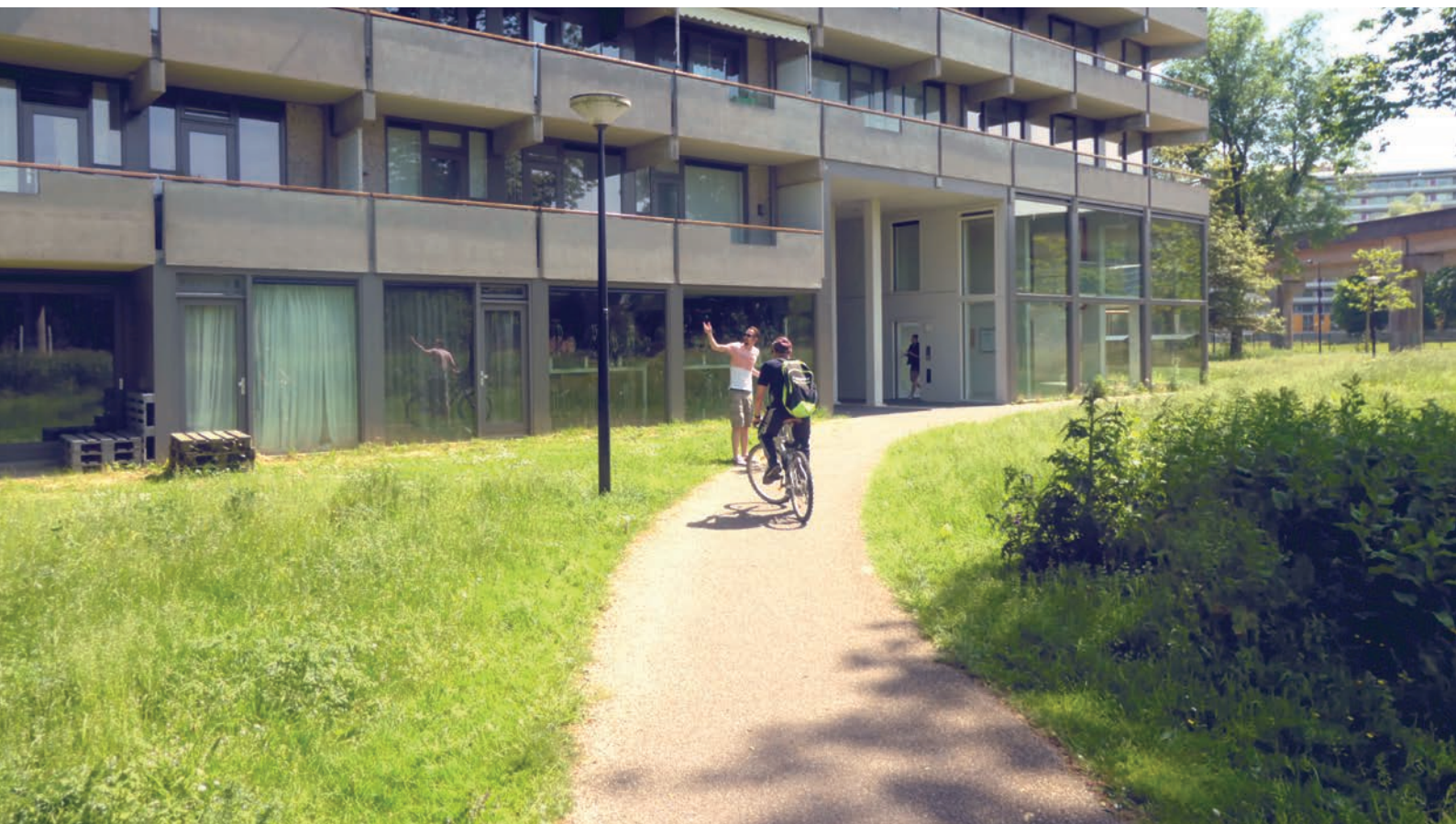
De open plinten van de Kleiburgflat zorgen voor meer verbinding met en sociale ogen op de omliggende groene openbare ruimte.
